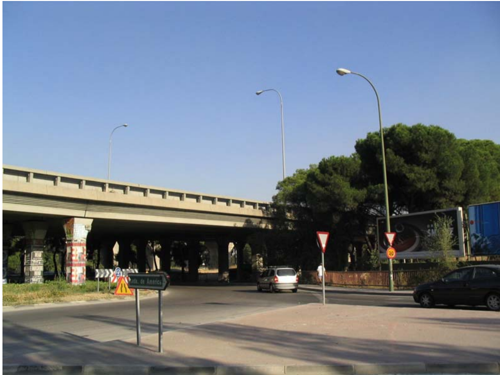
Foto 4.1 – Vista del viaducto del Paseo de Manuel Azaña
