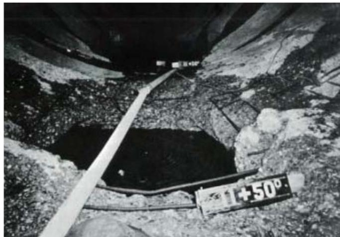
Foto 2.5.- Desconches en sostenimiento túnel
