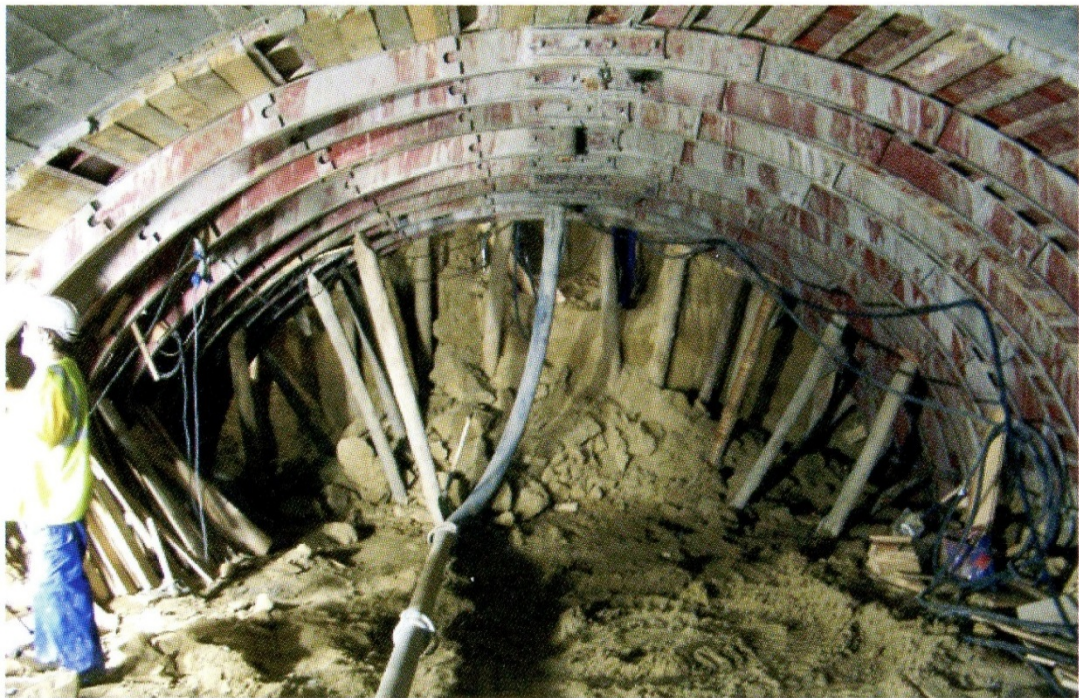
Foto 1.1.- Vista túnel Metro en Madrid ejecutado por método tradicional
