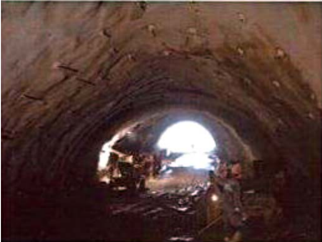
Foto 3.3 – Refuerzo sobre el gunitado con bulones autoperforantes
