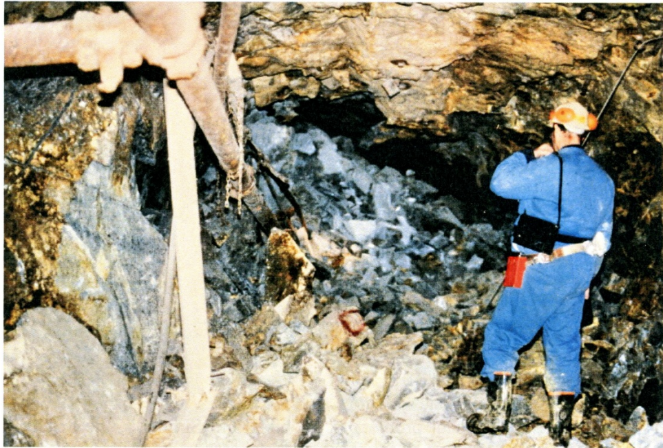
Foto 2.2.- Rotura galería minera por Rock-bursting
