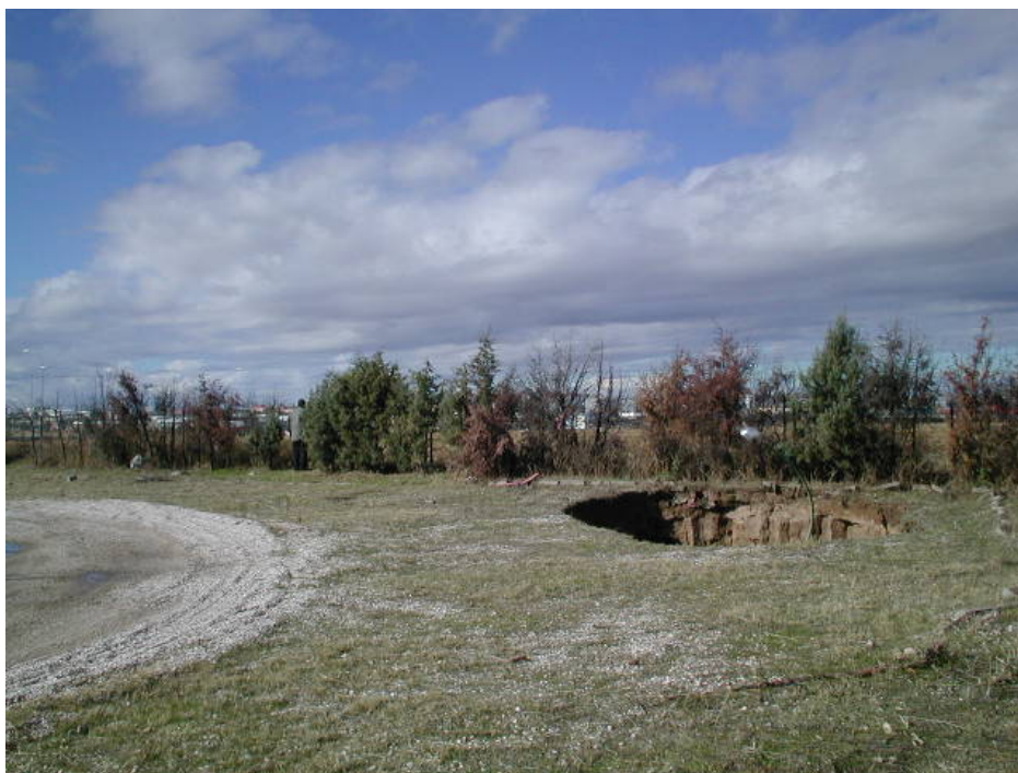
Foto 3.2.- Chimenea al paso de túnel interurbano realizado con tuneladora.
