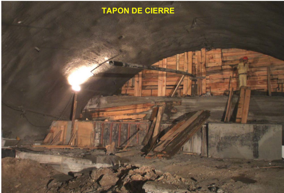
Figura 3.13.- Encofrado de tape frontal.
