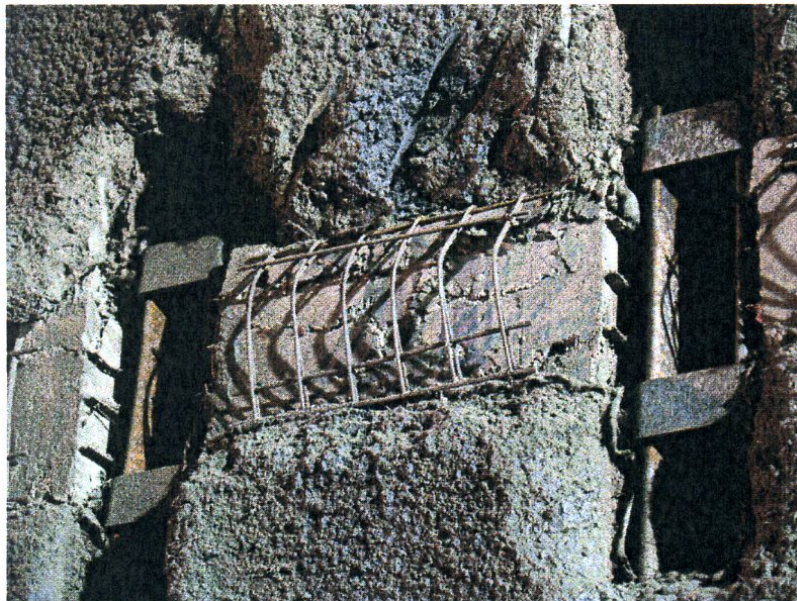
Foto 4.8.- Vista elementos HiDC colocados en la ranura de un túnel.
