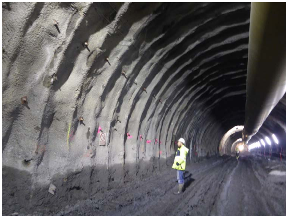
Foto 4.5.- Vista de un tramo con contrabóveda provisional en avance.
