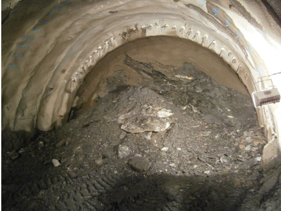
Foto 3.4.- Situación micropilotes de paso campana
