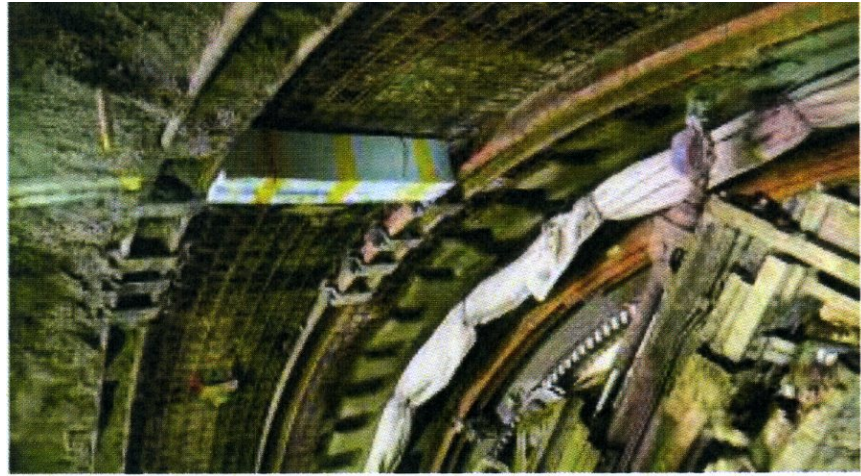
Foto 4.6.- Vista bandas deformables de foam
