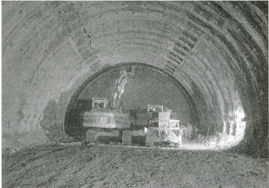
Foto 4.4.- Sostenimiento deformable método pasivo Túnel de San Gotardo.
