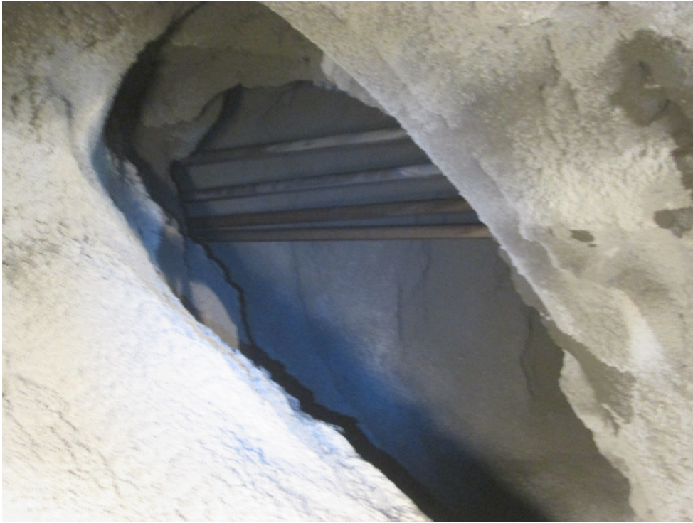
Foto 3.5 Vista de paraguas en vano de campana.
