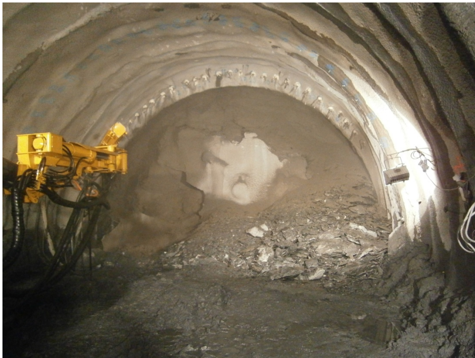
Foto 3.8.- Vista extensión paraguas respecto a campana.
