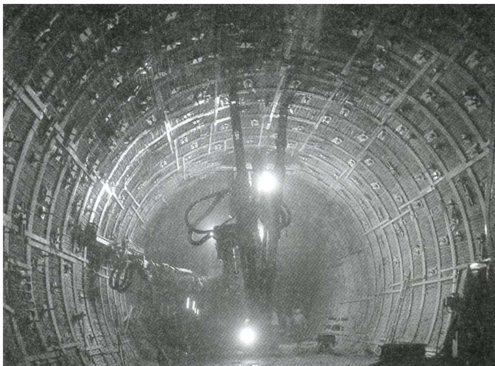
Foto 4.2.- Sostenimiento rígido con perfiles HEM-180. Túnel de San Gotardo
