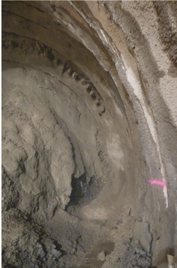
Foto 3.6.- Vista cercha provisional a retirar a una vez pasada la campana.
