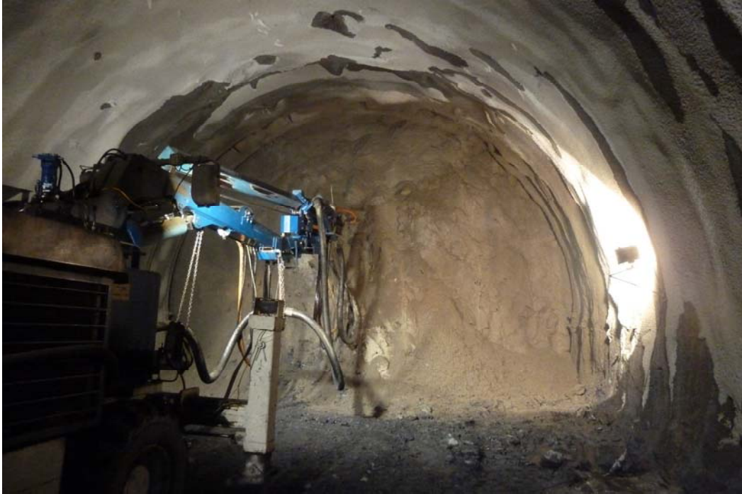
Foto 2.2.- Machón central en avance de dimensiones reducidas.
