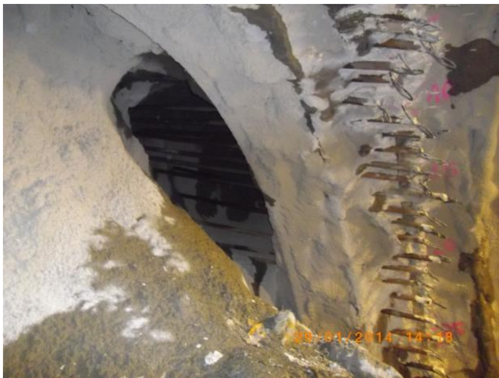
Foto 3.9.- Desvíos en micropilotes paraguas parte exento.
