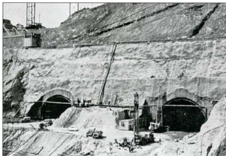
Figura 2.- taludes de emboquille de algunos túneles hidráulicos en la presa de Tarbela en Pakistán. (Beker, 1972) Obsérvense los arcos de sostenimiento de hormigón esquematizados en la figura 3
