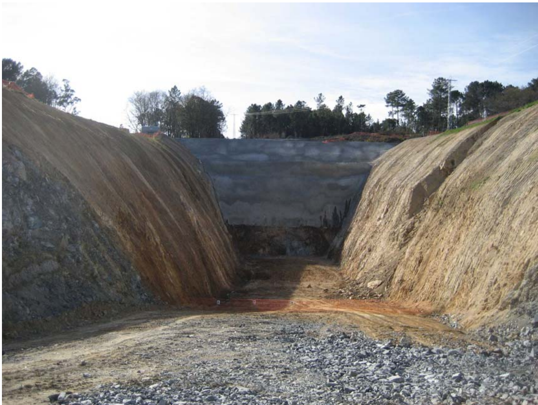
Foto 1.1 – Trinchera de emboquille
